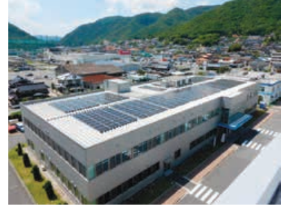
太陽光パネル(イーグル工業(株)岡山事業場)
