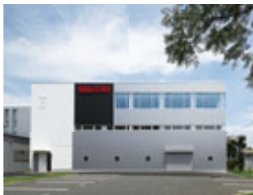
バルコム技術厚生棟
