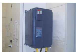
インバーター制御装置 古いタイプのエアコンに取り付けたインバーター制御装置。これにより、大幅な節電につながりました
