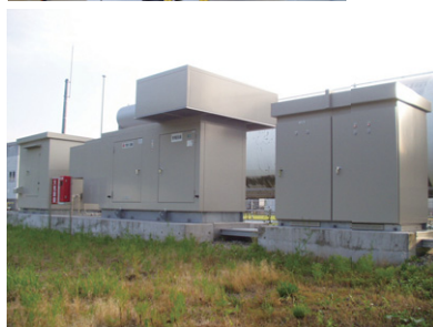
自家発電装置 計画停電の実施や、ピーク電力が基準値を超過する危険性が生じた場合の備えとして導入した自家発電装置(イーグルブルグマンジャパン)
