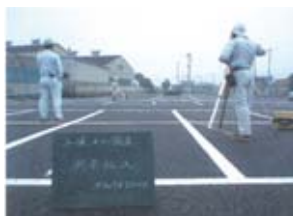
土壌ガス調査（測定）
