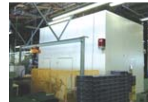
プレス防音ボックス(岡山事業場)
