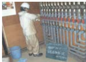
地下水調査（揚水井戸の試料採取）
