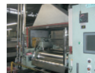
ロール安全対策 (岡山事業場) 非常停止時のエリアセンサーを見直しました。
