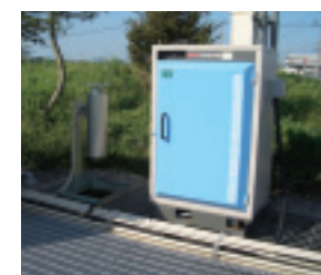
排水放流口へ異常排水監視装置を設置 (新潟事業場) 雨水系排水へ油等が流出しないことを濁度検出と油の有無で常時監視しています。異常があった場合は即座に排水ゲートが閉止し、近隣への汚染拡大を防止します。
