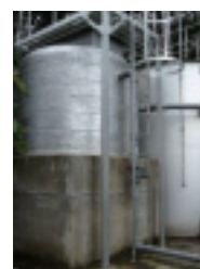
生活排水処理施設改修 (埼玉事業場) 生活排水汚泥槽を耐腐食性の高いFRP製に変更し、割れ等のリスク軽減及び長寿命化を図りました。
