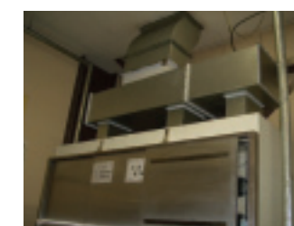
局所排気装置改修 (新潟事業場) 局所排気装置改修を行い、開口部をスライド式にすることで、有機溶剤の拡散の防止をしました。
