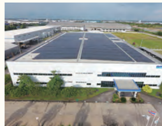
工場の屋根に設置した太陽光パネル
