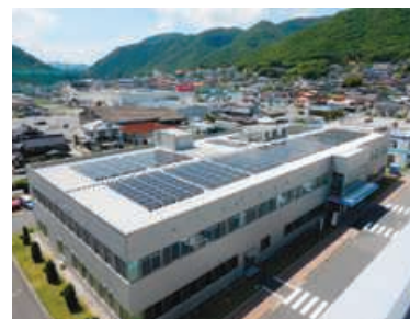
太陽光パネル(イーグル工業(株)岡山事業場)
